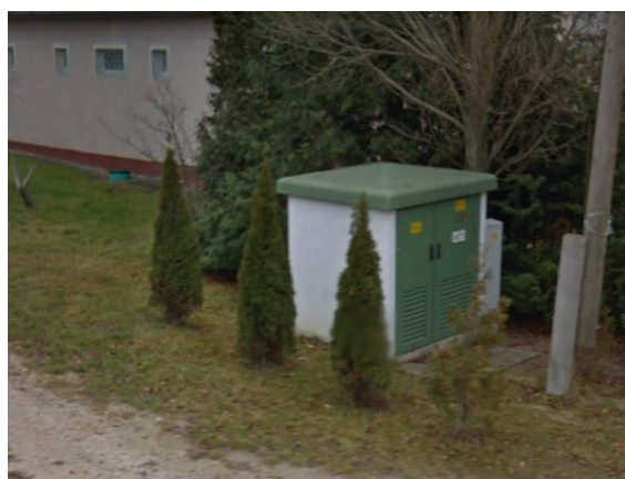
91. ábra: Dörgicse ksg. 44775 sz. 20/0,4 kV-os tranzformátor
