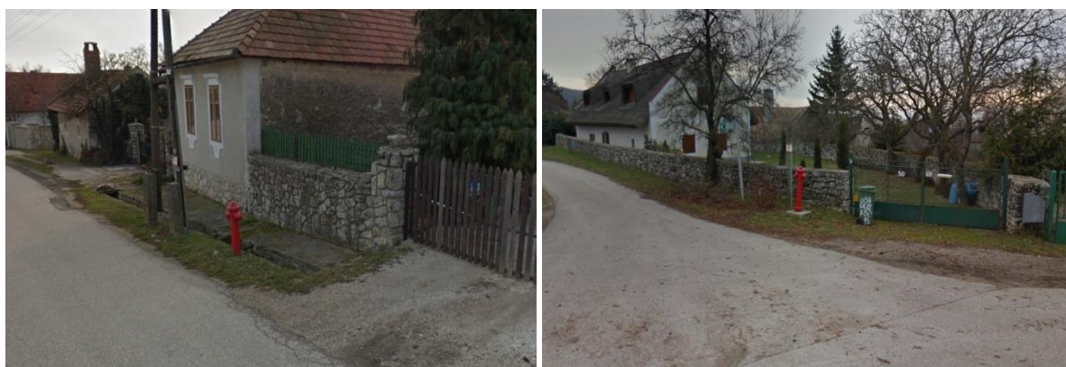
87. ábra: Föld feletti tűzcsap kialakítások a településen (forrás: maps.google.com)
