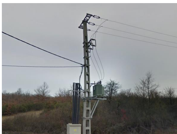
90. ábra: Kisdörgicse 44776 sz. 20/0,4 kV-os oszloptranzformátor
