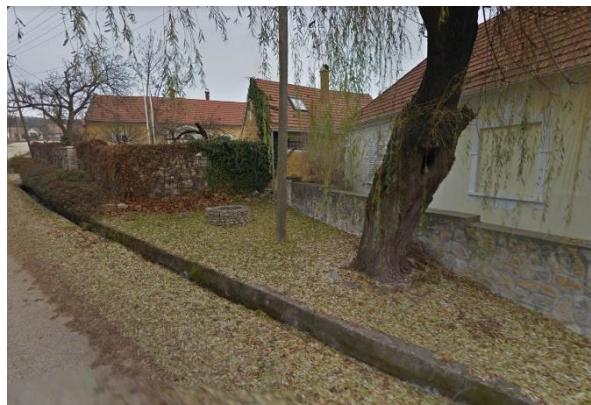
89. ábra: Csapadékvíz-elvezető nyílt árkos kialakításai (burkolatlan és burkolt) a településen (forrás: maps.google.com)
